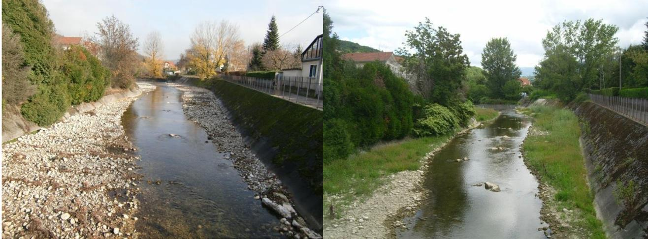
Figure 7 : Exemple d'impact paysager de l'implantation de risbermes en période d'étiage après travaux et 1 an après (Source : Biotec)
